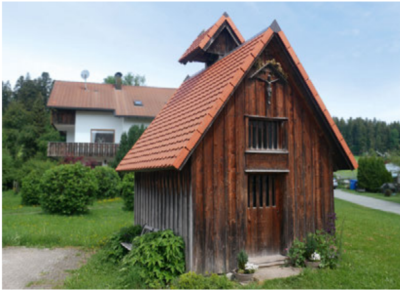
Oben: die Martinakapelle in Schalkenried. Rechts: der Innenraum des winzigen Gotteshauses.
